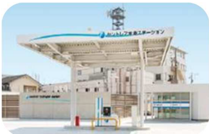
水素ステーションの一例（セントレア水素ステーション）
