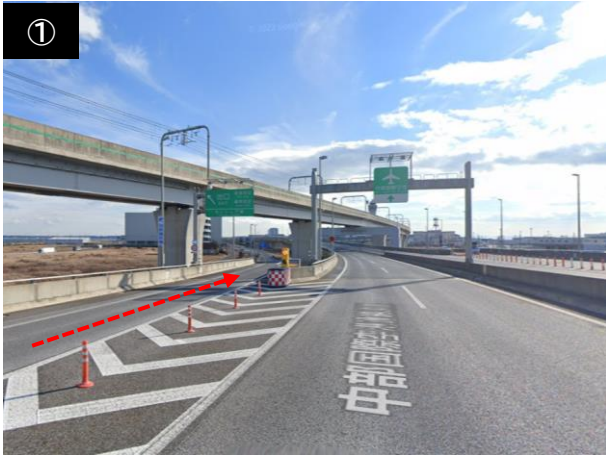
中部国際空港連絡道路 「セントレア東IC」でおります。
