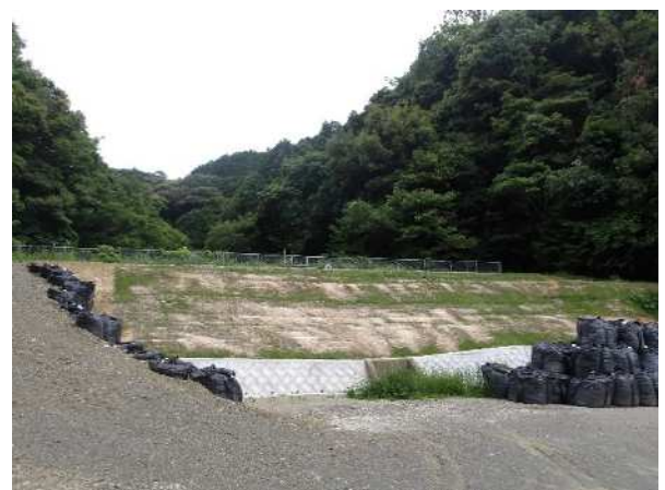
堤体の整備（新城市黒田上の池地区）
