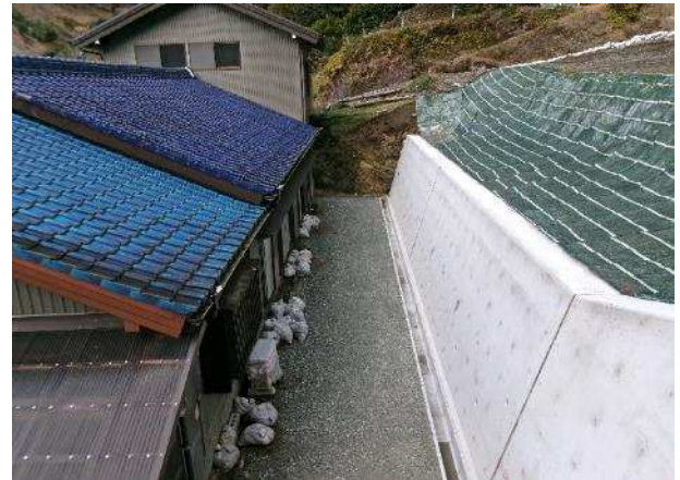
土留工（復旧後）
