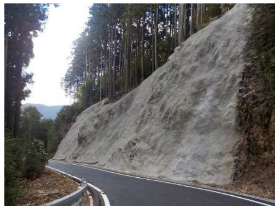
林道改良事業（改良） 神田道瓦線（新城市）
