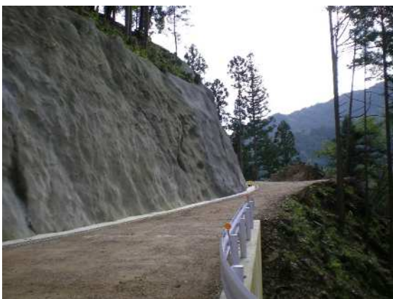
過疎山村地域代行林道事業（開設） 手澤線 2 工区工事（豊根村）
