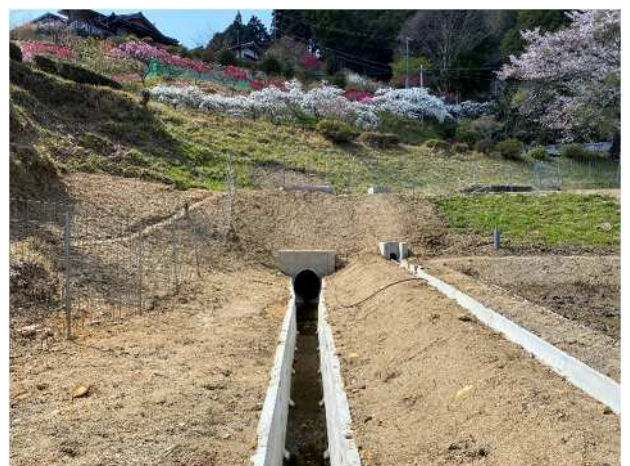
用排水路の整備（設楽町田峯地区）
