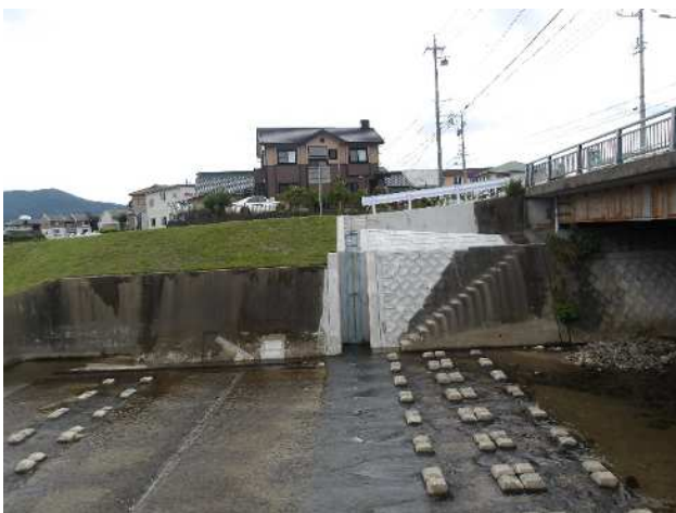
取水堰の整備（新城市野田地区）
