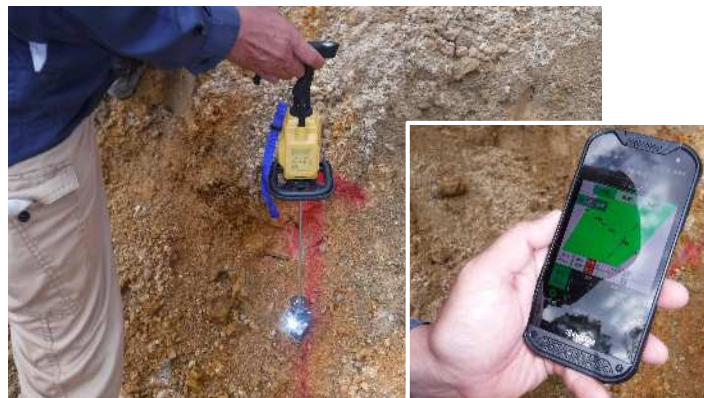
リモートコントロールシステム（TS遠隔操作）を用いた掘削前確認
