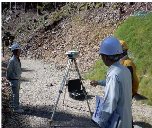
起工測量時の立会状況
