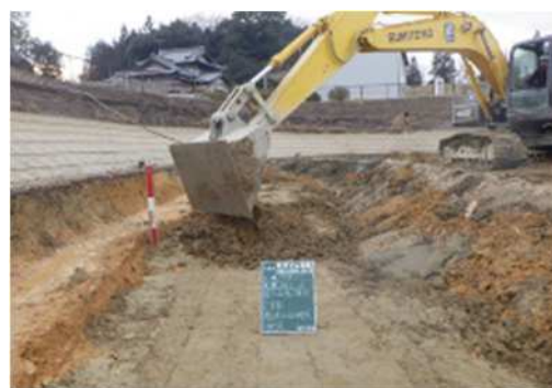
堤体押さえ盛土の施工状況 (防災ダム事業 八木池上池・下池地区 上池 池の内側)
