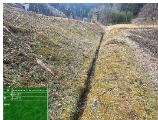
工事前の排水路 (大野瀬地区)
