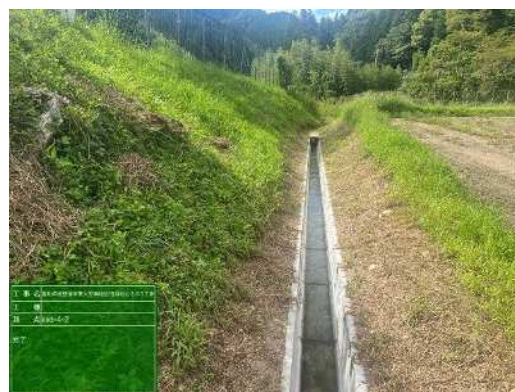
工事により整備された排水路 (大野瀬地区)
