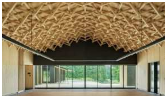
現地の間伐材を利用した立体トラス構造の梁
