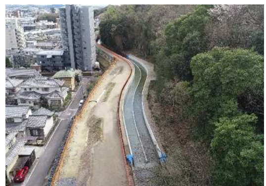
工事が完了し耐震化された枝下用水幹線水路 (枝下用水地区)
