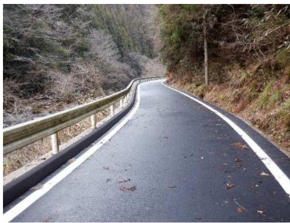
走行の安全を高める舗装
