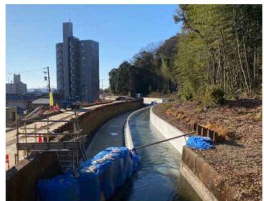
枝下用水幹線水路の改修工事 (枝下用水地区)
