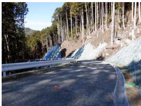
県営事業による林道開設
