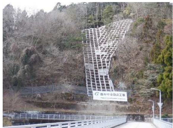
山腹崩壊地に施工した法枠工
