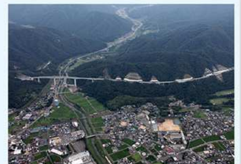
舞鶴若狭自動車道 敦賀衣掛大橋(福井県敦賀市)
