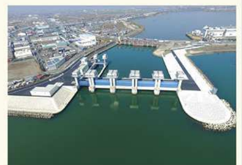
日光川流域の防災の要 日光川水閘門
