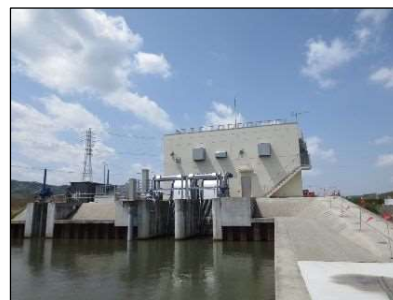
菱池排水機場（全景）
