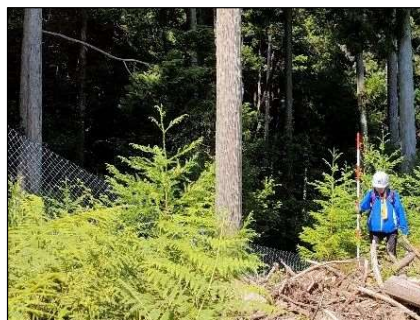
獣害防止施設点検状況
