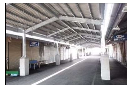
整備された屋根施設
