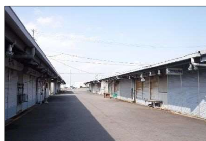
屋根整備前の様子
