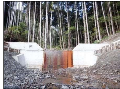
治山ダム工（コンクリート）
