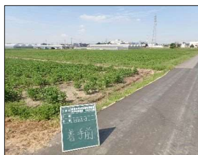
工事施工前の状況
