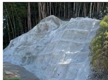
法枠工（簡易法枠工）
