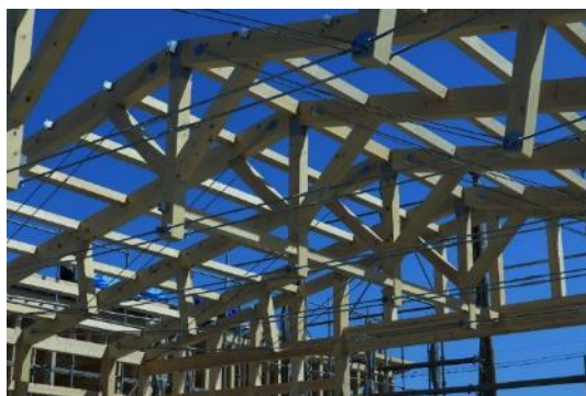
▲ 建設中の西棟内観
