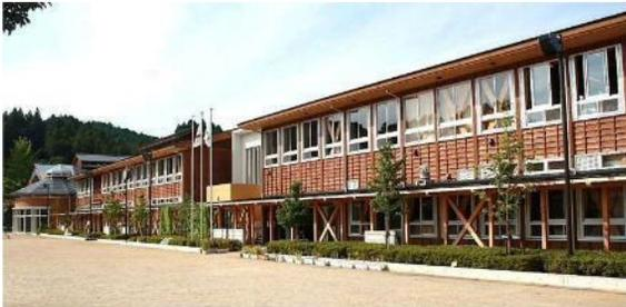
構造／校舎棟：木造一部鉄筋コンクリート造 2階建て
