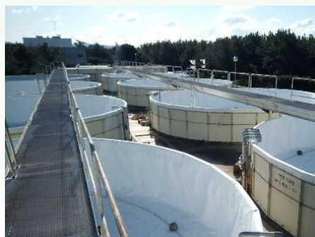
栽培漁業センターの整備事例 (クロレラ培養施設水槽 キャンパスの更新)
