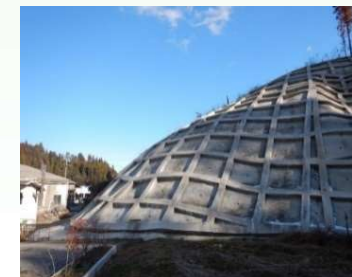
急傾斜地崩壊対策の事例
