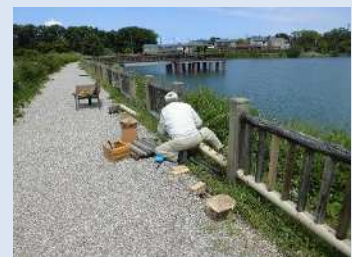
ため池木柵の補修状況
