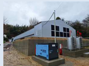
畜産クラスター事業で 整備した鶏舎
