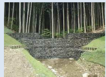
治山施設の整備
