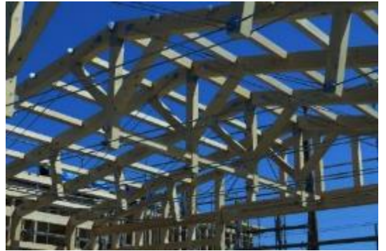
▲ 建設中の西棟内観
