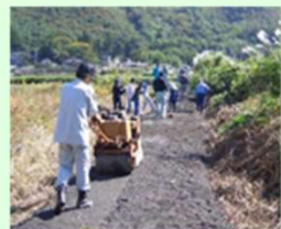
未舗装農道の舗装
