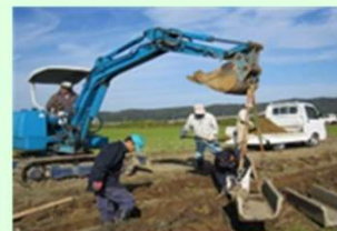
コンクリート水路の更新
