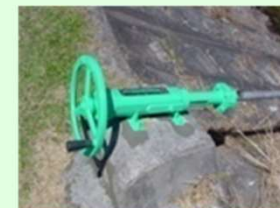
ゲート、バルブの更新
