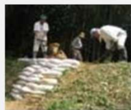
漏水箇所の補修
