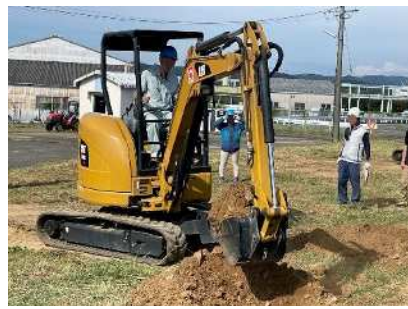
小型車両系建設機械研修
