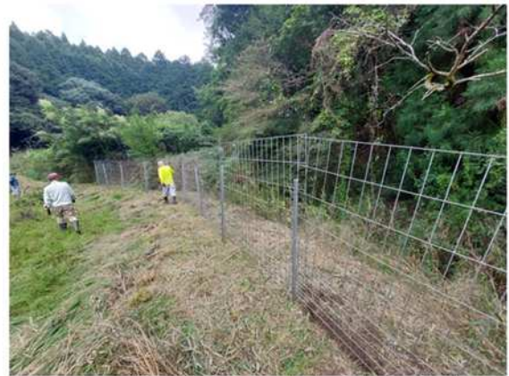
写真3 侵入防止柵の保守点検・草刈り
