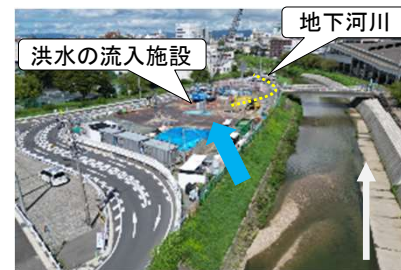
河川海岸整備
