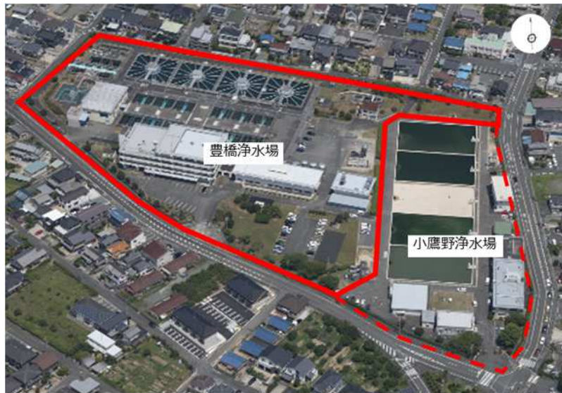
豊橋浄水場全景
