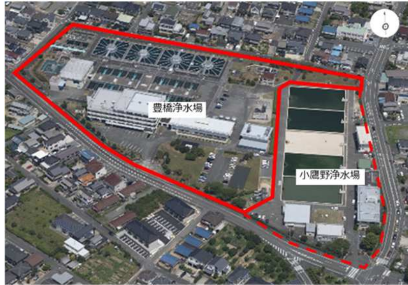
図表1 豊橋浄水場全景
