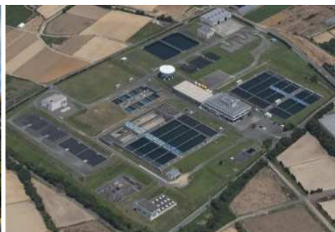
水道施設(浄水場)
