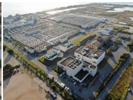
下水道施設(下水処理場)
