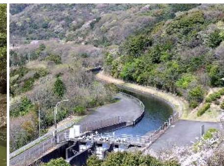
農業水利施設(農業用水路)
