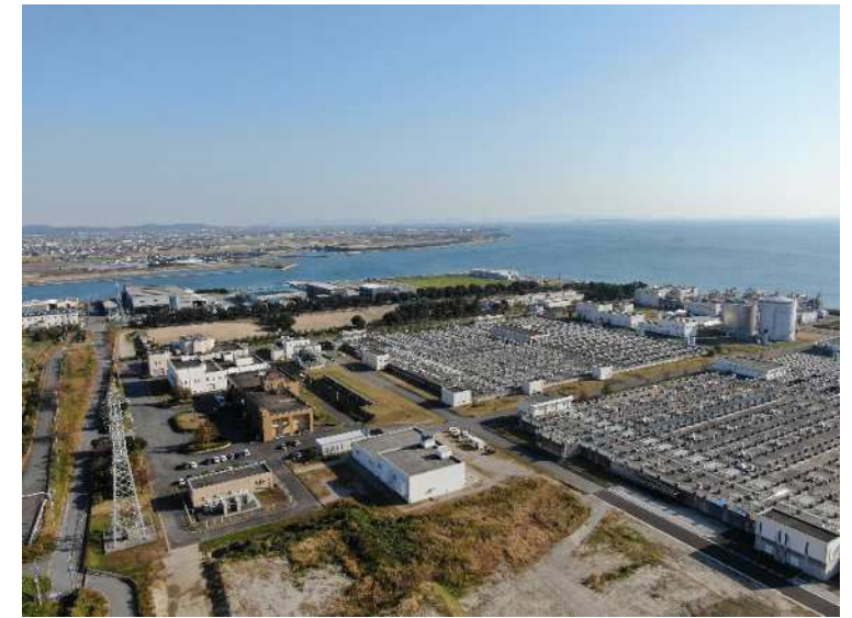
【再エネ】1-4. 水インフラ空間における太陽光発電施設の設置 矢作川浄化センター全景
