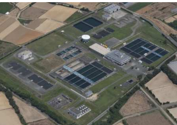
上工下水道施設(浄水場)
