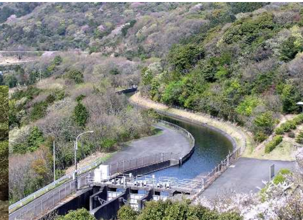
農業水利施設(農業用水路)
