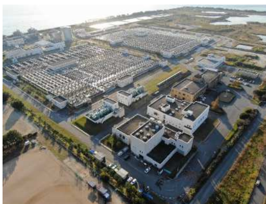
上工下水道施設(下水処理場)
