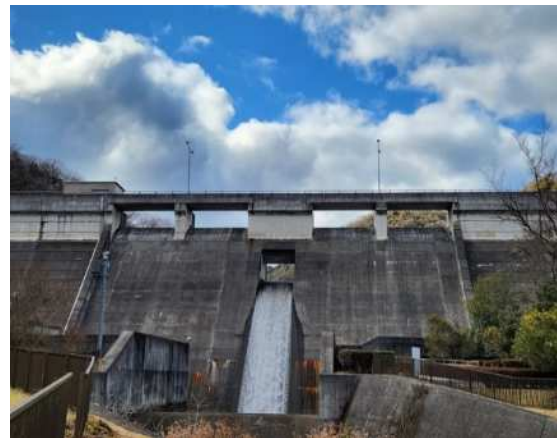
河川施設(ダム)
