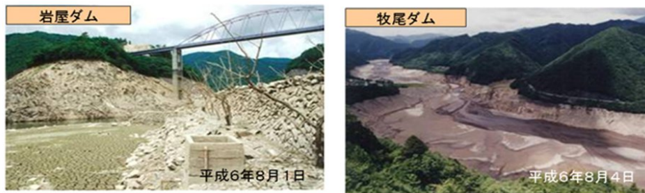
1994年のダム枯渇写真（中部地方整備局HPより）
