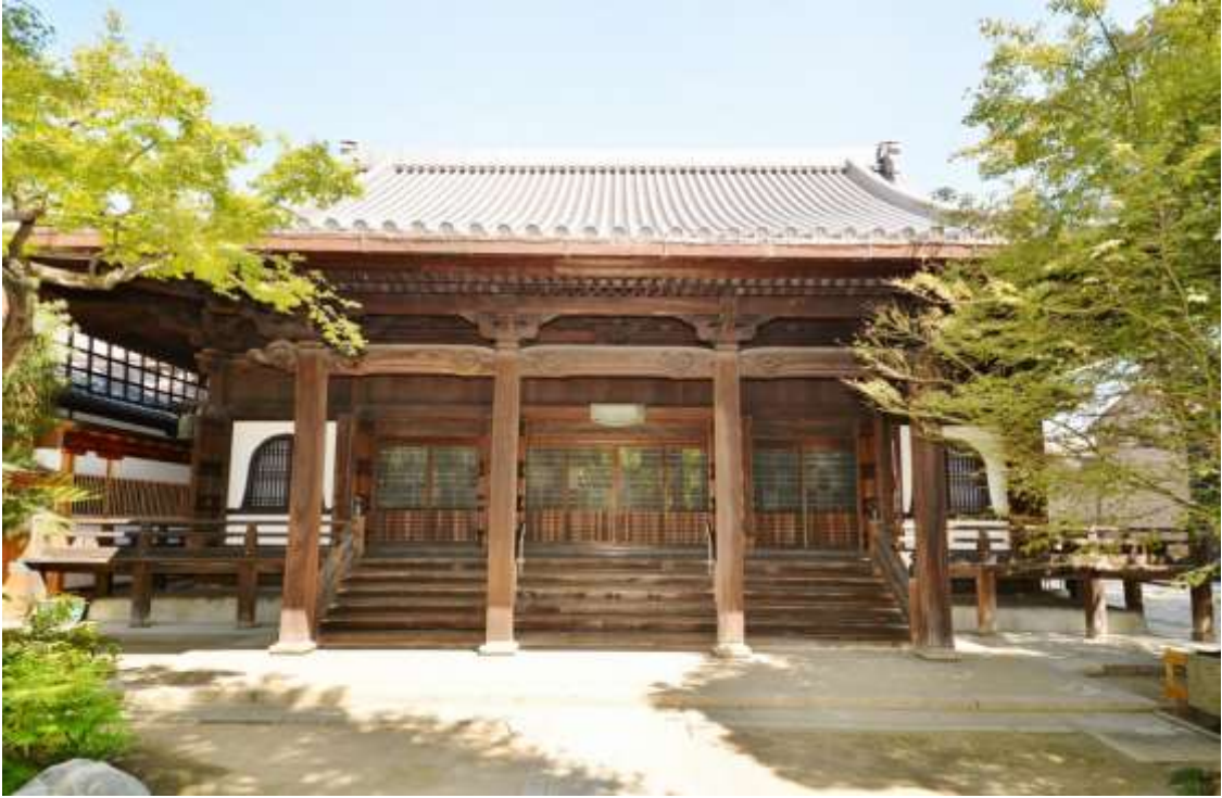
本堂正面 南西 外観全景（名古屋市教委提供）
