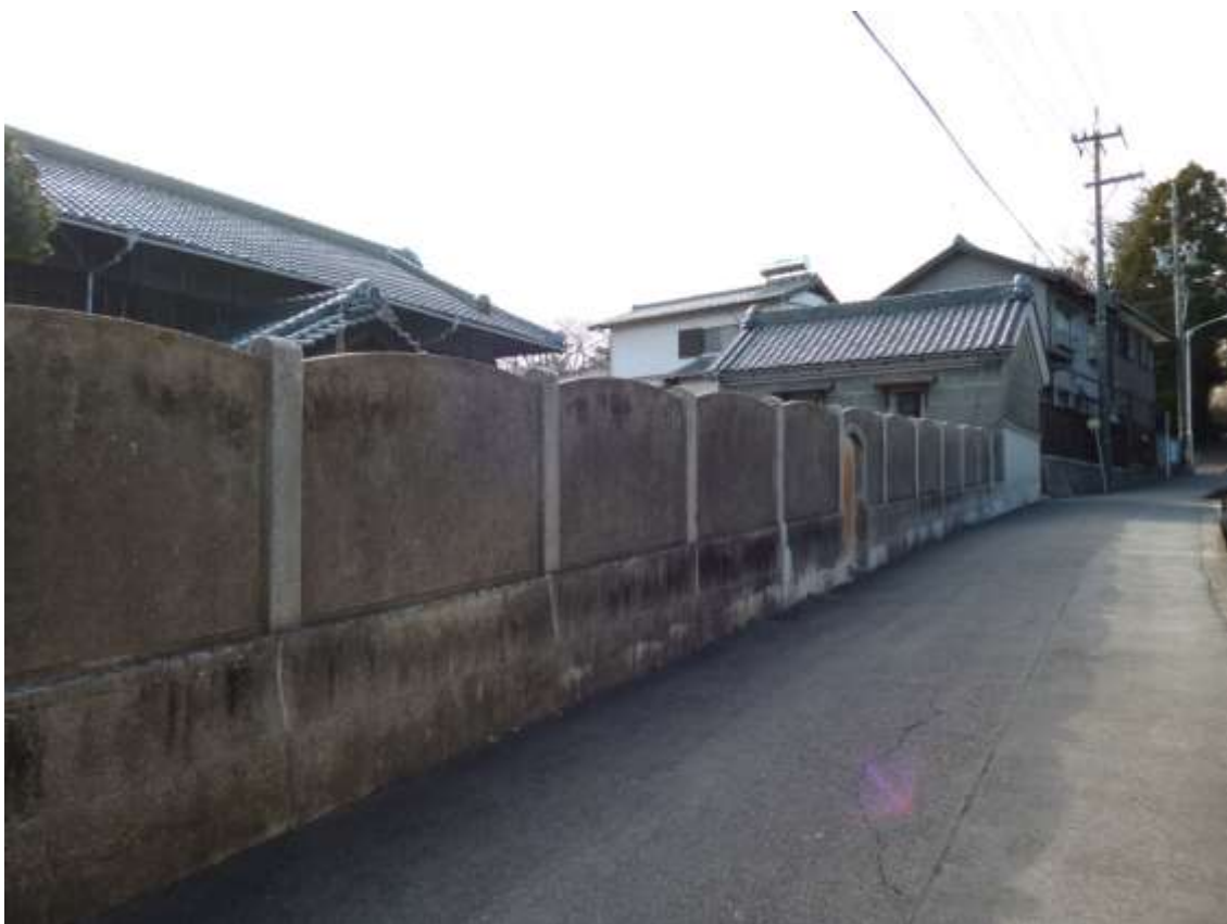
塀 道路より南を望む（知多市教委提供）
