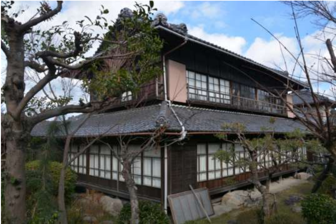
旧岡田医院主屋 庭より北を望む（知多市教委提供）
