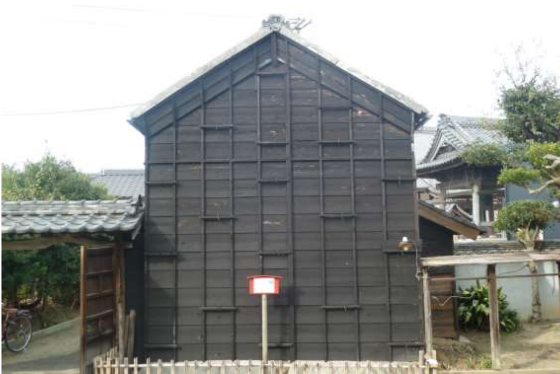
南土蔵 東から (あいちヘリテージ協議会提供)
