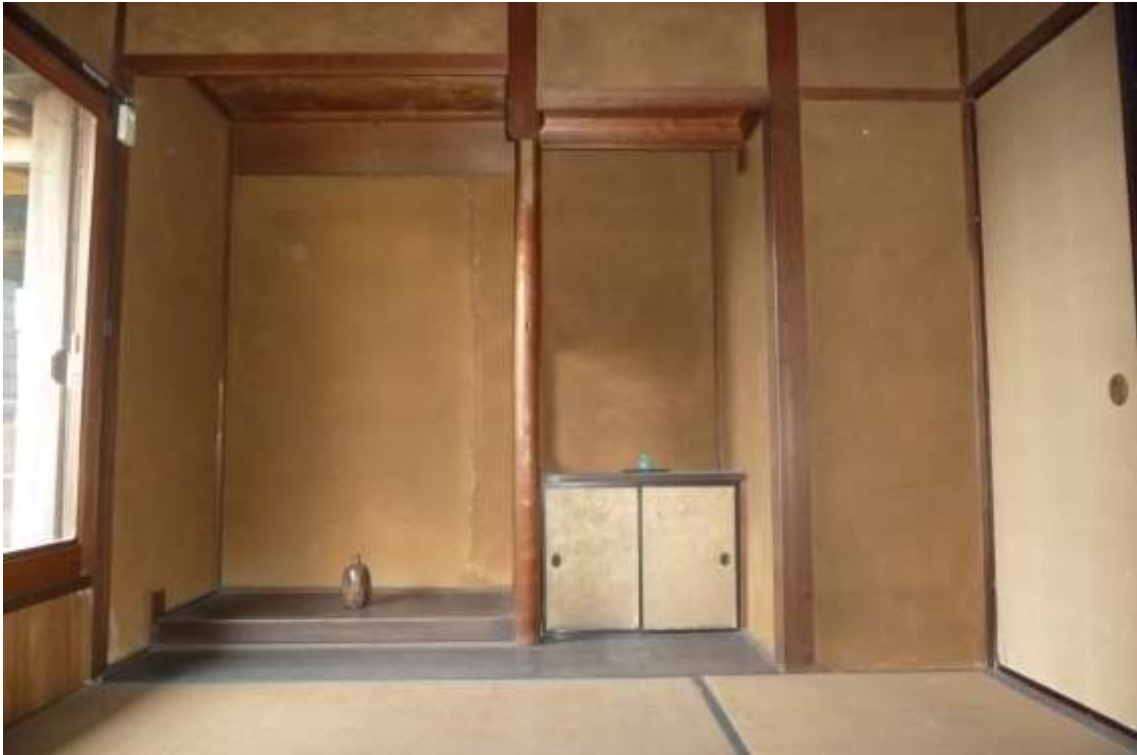
奥座敷 床の間 北から (あいちヘリテージ協議会提供)
