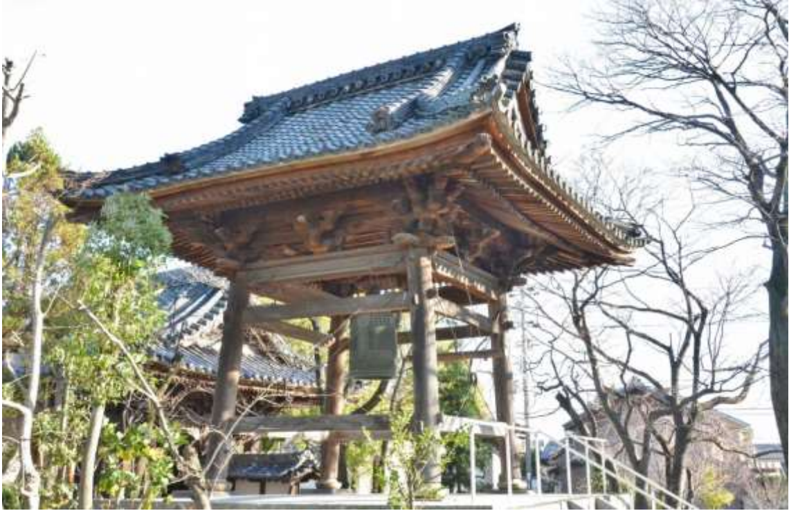
鐘楼 南西面外観（知立市教委提供）
