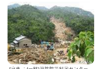
[出典：(一財)消防防災科学センター「災害写真データベース」]
