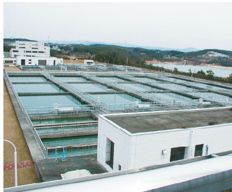
尾張東部浄水場
