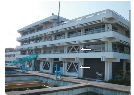
建物の耐震化事例（豊橋浄水場）
