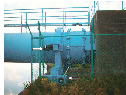
上部工落橋防止設備の事例（筏川第2水管橋）
