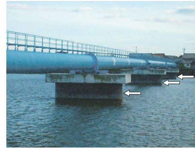
下部工耐震補強の事例（筏川第2水管橋）
