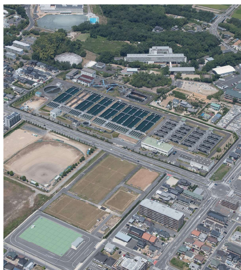
豊田浄水場 (2018年8月撮影)
