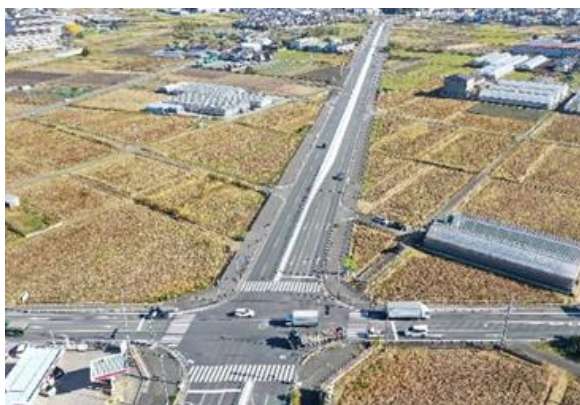
【東三河環状線（大崎工区）】 (豊川市)
