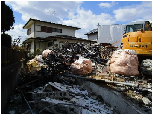
【解体工事現場の様子】
