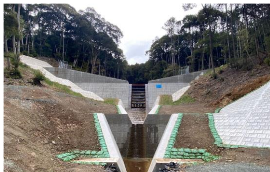
【砂防堰堤の整備（豊川市）】
