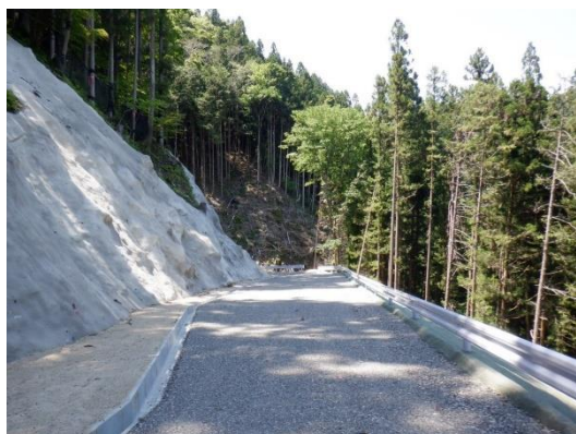
【林道開設状況】
