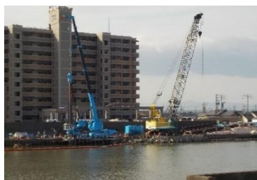
【新川 鋼矢板打設状況】
