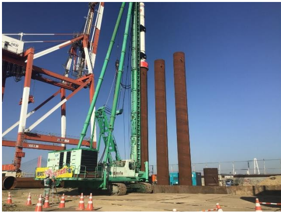
【飛島ふ頭の耐震強化岸壁】
