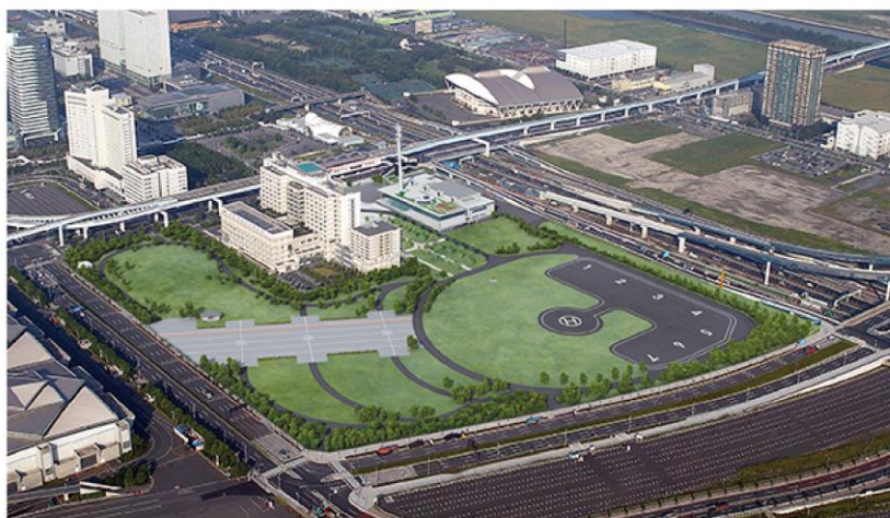
東京臨海広域防災公園HPより
