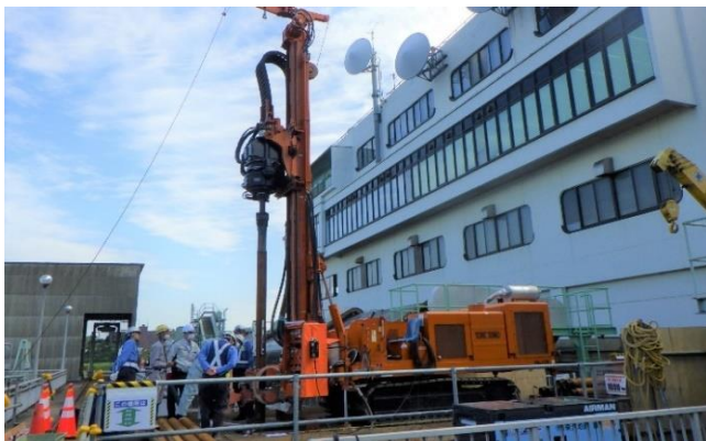
【排水機場の基礎の耐震化】
