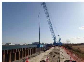
【東浦海岸 鋼矢板打設状況】
