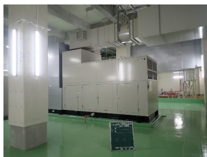
【非常用自家発電設備の整備】 日光川下流域下水道 弥富ポンプ場 （弥富市）
