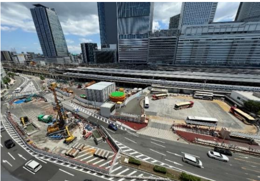
【名古屋駅（中央西工区）】
