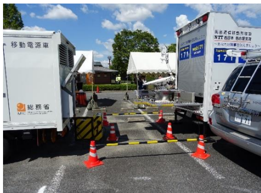
【移動電源車からの電源供給訓練】
