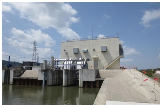
【整備完了状況】
