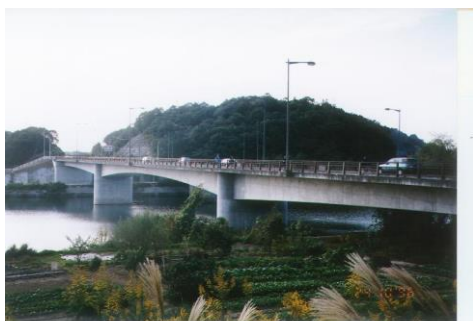
【(一) 豊田環状線・山室橋】
