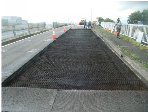
【（主）あま愛西線・古瀬南橋取付部函渠】
