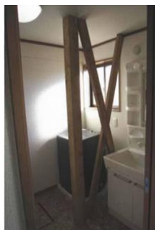
【戸建住宅の耐震改修】
