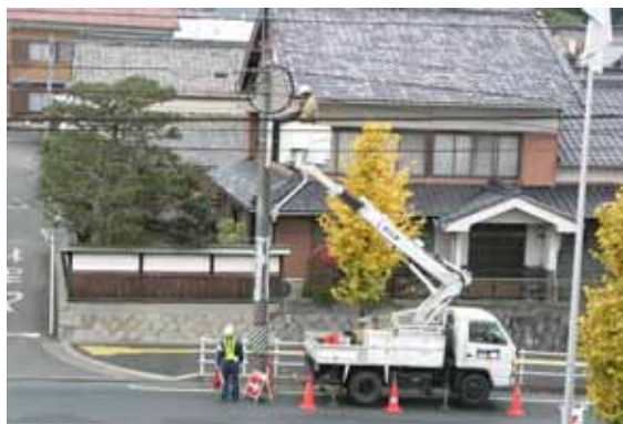
架設中のCATV網（新城市）
