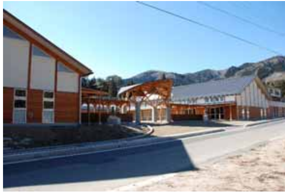
三河材を活用した設楽町立名倉小学校
