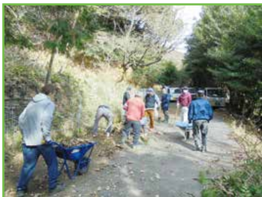
鳥獣害防護柵の修繕
