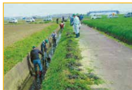
地権者と排水路清掃
