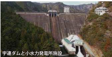
宇連ダムと小水力発電所施設
