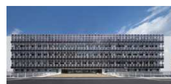
10 環境調査センター・衛生研究所
