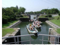
水位を調整する開室に長良川側より入るところ。
