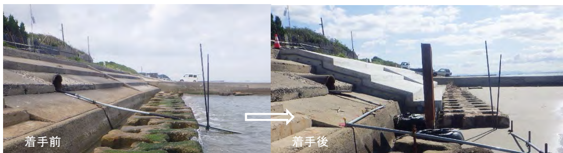
洗掘対策（愛知県知多郡美浜町） 資料：愛知県
