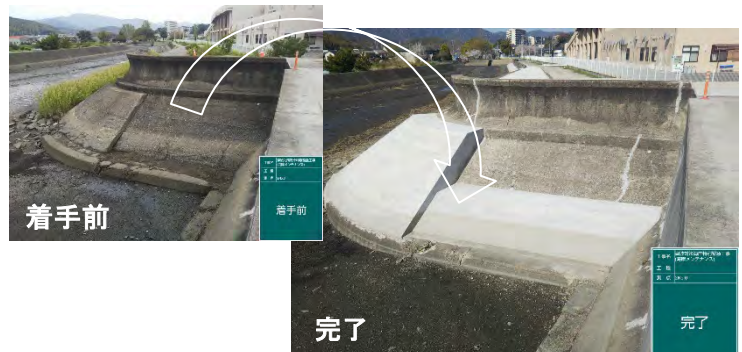
堤防の補修 (蒲郡海岸：愛知県蒲郡市)
