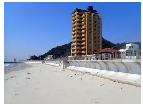
老朽化した堤防の前面に大型波返し護岸（高さを低減）を設置（南知多海岸）
