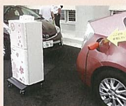
避難所への電源供給実証
