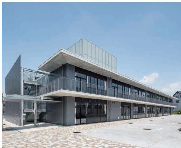
路盤材(RC-40)、集水桝、境界ブロック [三河高等技術専門校第1実習棟]
