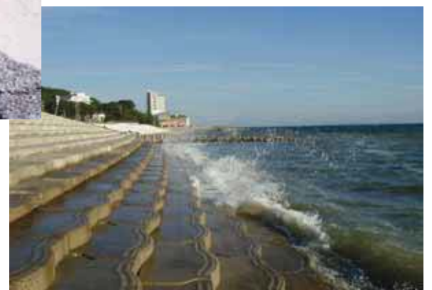
構造物設置後の状況
