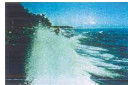
越波状況（三重県二見町） 資料：「伊勢湾沿岸整備マスタープラン」（三重県）
