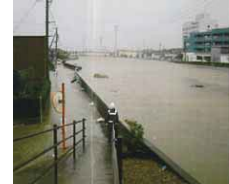
平成 21 年 台風 18 号時の二級河川 汐川での高潮遡上状況(田原市)
