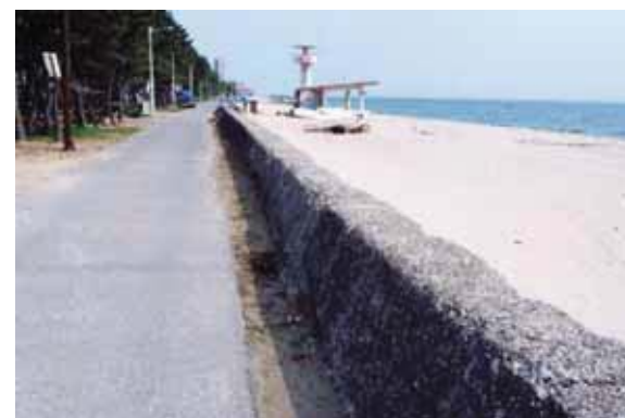
構造物設置前の状況 (愛知県美浜町)
