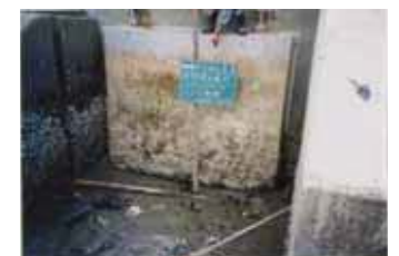
ヘドロの堆積（フラップゲート） 資料：三重県
