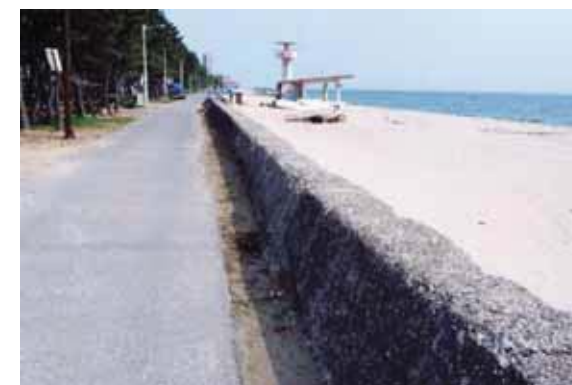
構造物設置前の状況 (愛知県美浜町)
