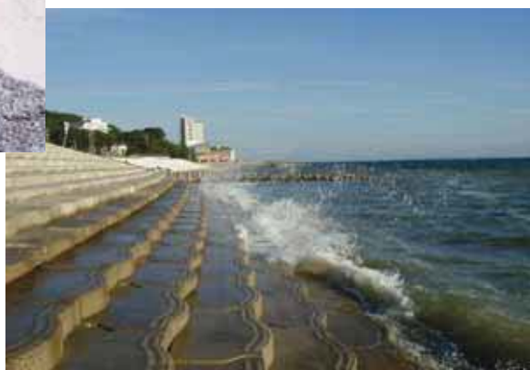
構造物設置後の状況
