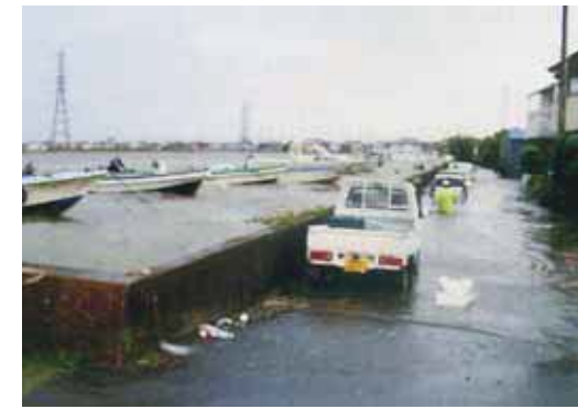
平成 21 年 台風 18 号時の二級河川 柳生川での高潮遡上状況(豊橋市)
