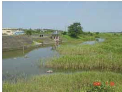
堤防背後の湿地（三重県明和町）
