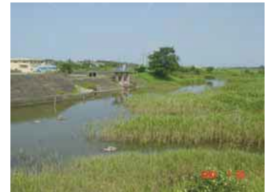
堤防背後の湿地（三重県明和町）
