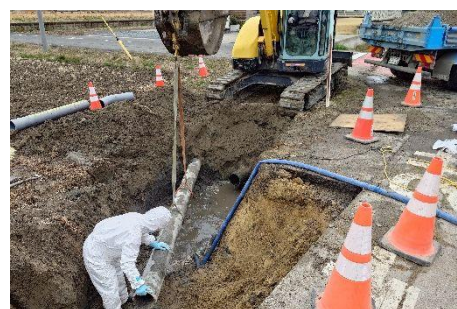
【石綿セメント管の撤去】（弥富市）
