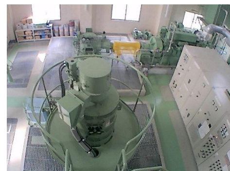
【排水機場の整備】（飛島村）
