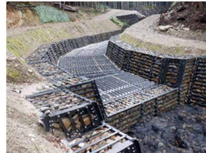
流路工（鋼製自在枠）
