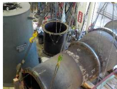
ポンプの分解整備状況（西尾市）
