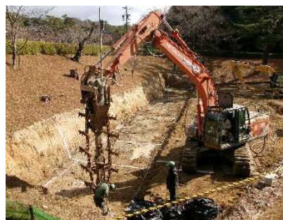
足延池の堤体補強状況
