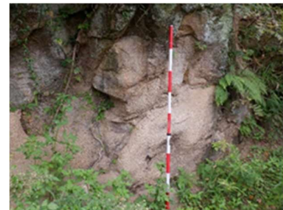
山腹の荒廃状況
