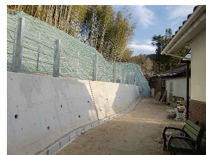
土留工（コンクリート）
