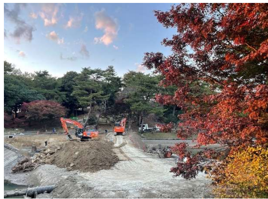
鳩ヶ池の洪水対策施工状況(岡崎市)
