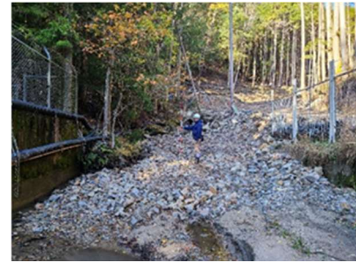
井沢取水場への土石流入状況
