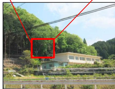
一時避難所(旧大雨河小学校)
