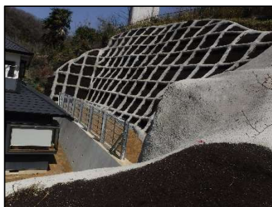
土留工と簡易法枠工(岡崎市)
