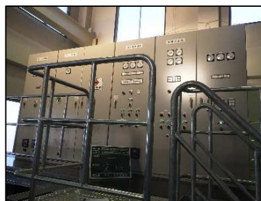
ポンプの電気設備の更新
