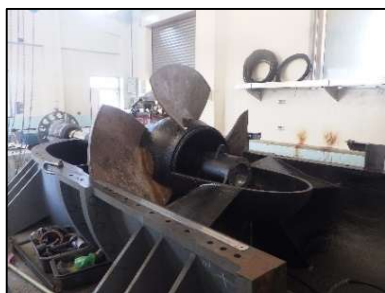
分解整備されたポンプの据付状況
