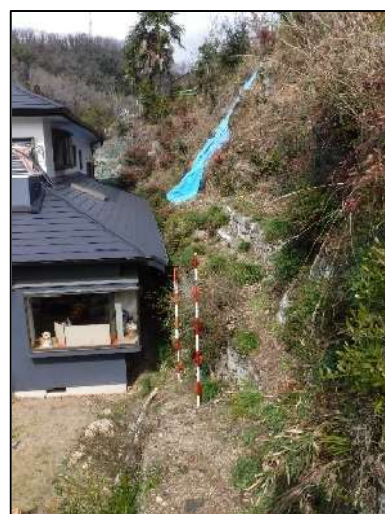
施工前の状況
