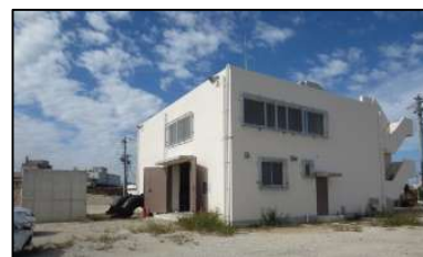
新前新田排水機場(建屋)
