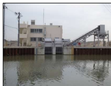
新前新田排水機場(正面)
