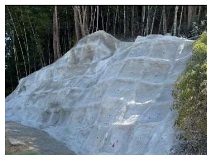
法枠工（簡易法枠工）
