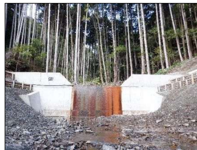
治山ダム工（コンクリート）
