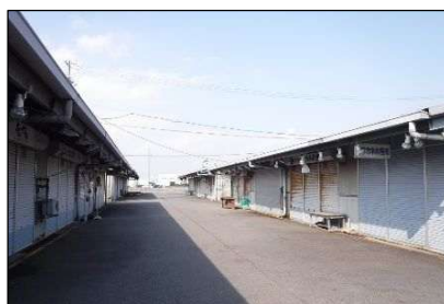
屋根整備前の様子
