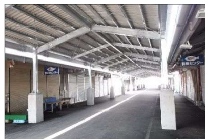
整備された屋根施設
