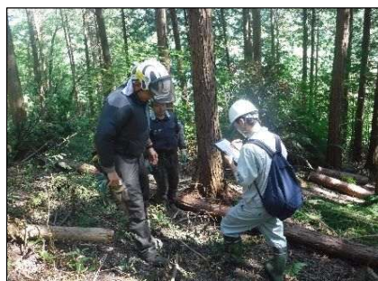
安全点検状況
