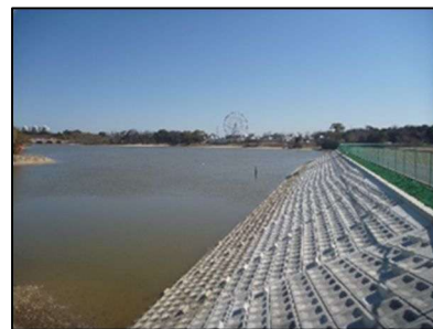
補強された堤体
