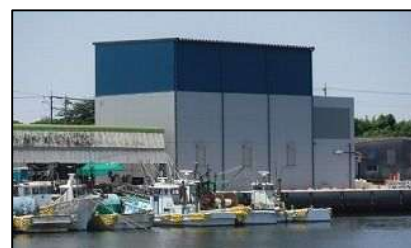
完成した製氷貯氷施設
