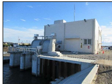
大岡排水機場(全景)
