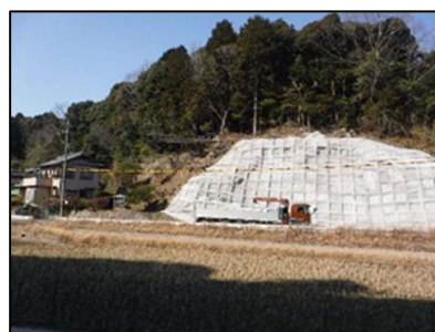
法枠工(簡易法枠)遠景
