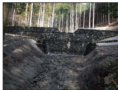
治山ダム(鋼製自在枠)近景
