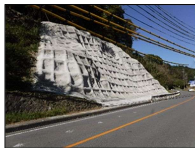
法枠工(簡易法枠)近景
