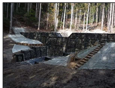
治山ダム(鋼製自在枠)遠景
