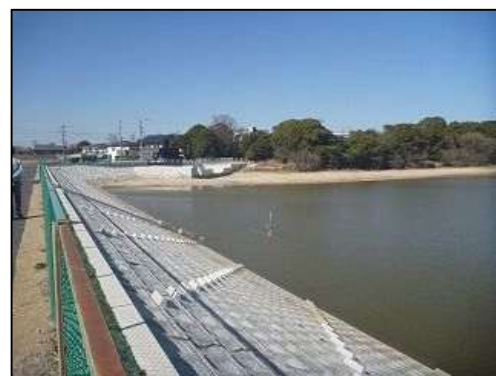
防災ダム事業 岩ヶ池（刈谷市）
