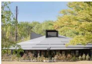
写真：Tezuka Architects
