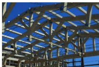
▲ 建設中の西棟内観
