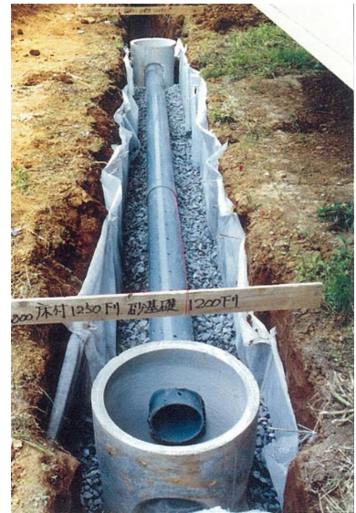
図 8-5 充填砕石工の完了
