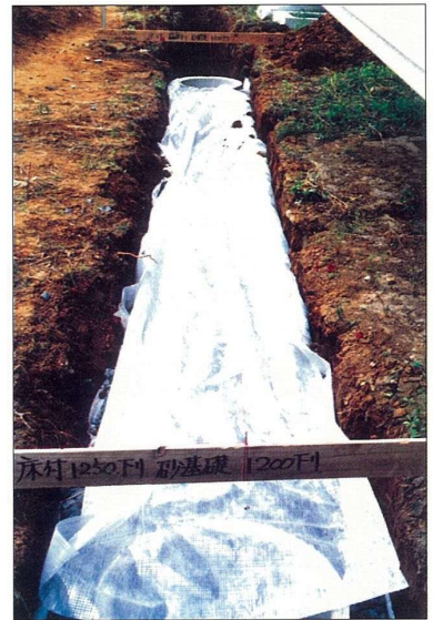
図 8-6 透水シート覆工後の状況
