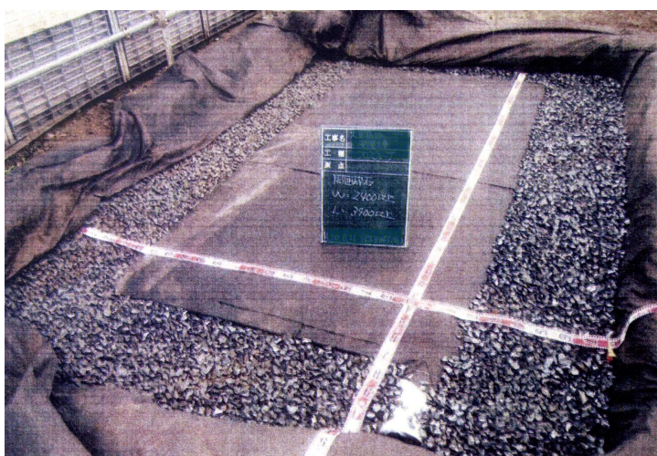
図 8-13 地下埋設部の出来形写真の例
