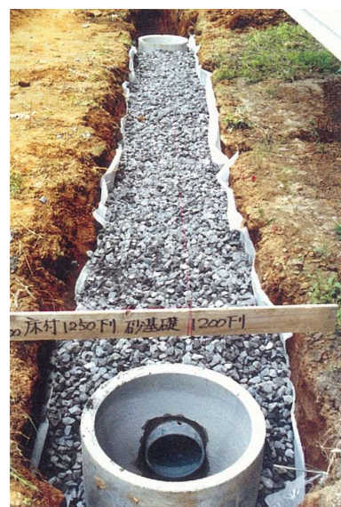
図 8-4 ます、透水管の据付
