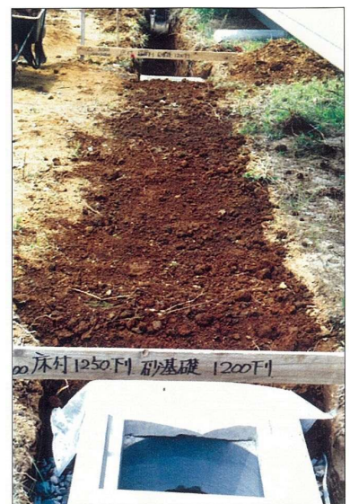
図 8-7 埋戻し状況
