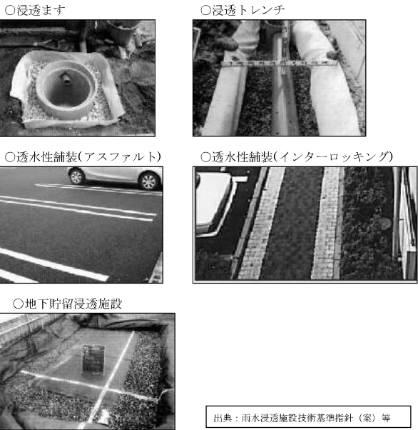
図3-1-1 浸透施設の例
